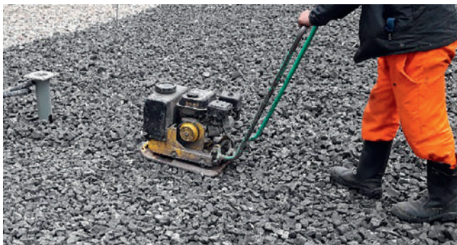
Рис. 7. Пример выполнения работ с использованием виброплиты
