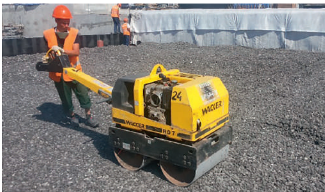
Рис. 8. Пример выполнения работ с использованием виброкатка
